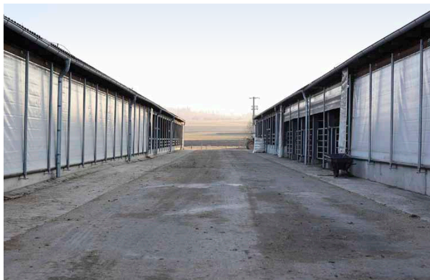
K bývalému kravínu a teletníku se při rekonstrukci přidaly boční přístřešky (foto: Karel Melger)
