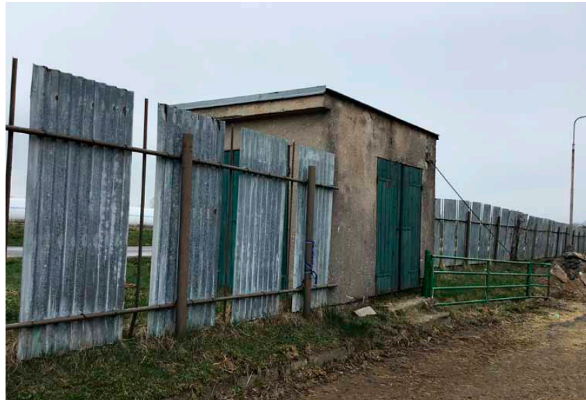
Správně umístěný kafilerní box na hranici farmy, jež nevyžaduje vjezd vozidla kafilérie na pozemek farmy (dva vstupy – jeden vnější pro přístup zaměstnanců obsluhujících kafilerní vůz, druhý vnitřní pro možnost uložení uhynulého zvířete pracovníky farmy) (foto: Leona Pekáriková, MSD Animal Health)
